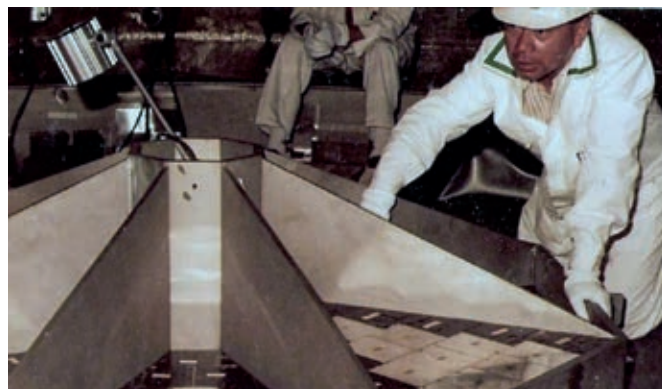
Neratoom/Kalkar (1972-1986): controle van het decontaminatie reactorbodemschild dat later gevuld zal worden met UO 2 kristallen.
